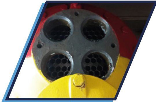
Mantenición a condensadores de amoniaco, cambio de ánodos de zinc y aplicación de cerámico.
