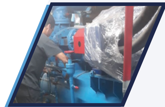
Instalación del sistema control en planta mycom.
