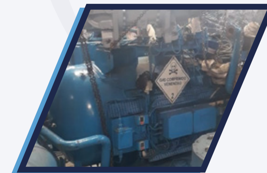
Montaje de nueva unidad compresor.
