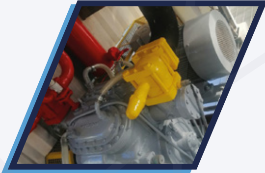
Mantenición preventiva a compresores de pistón mycom.
