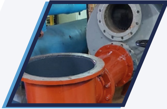
Mantenición a unidades Chiller.
